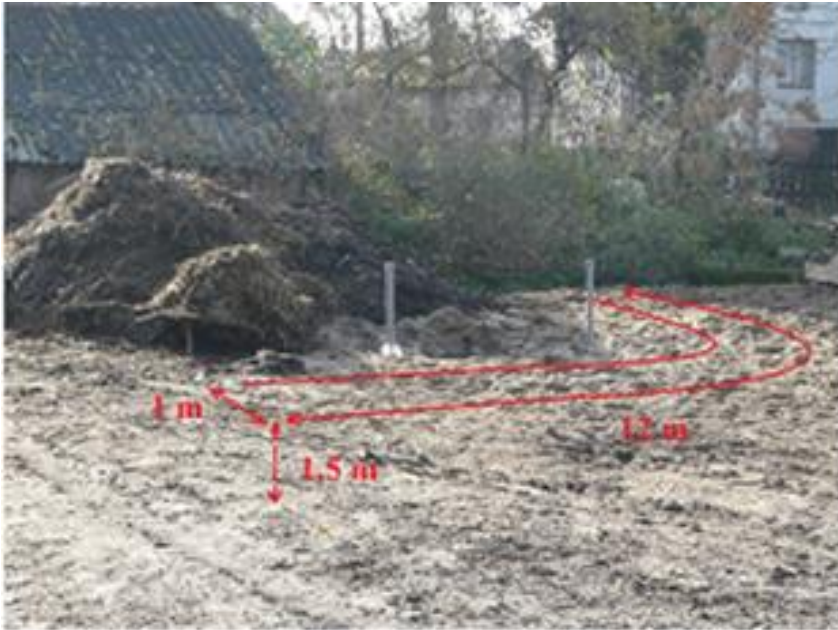
Sposób rozmieszczenia złoża biologicznego wokół składowiska obornika
