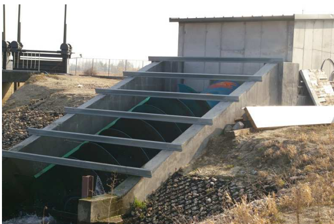
Rysunek 20 Hydroelektrownia w Zygmuntowie z zainstalowaną na kanale obiegowym turbiną Archimedesesa
