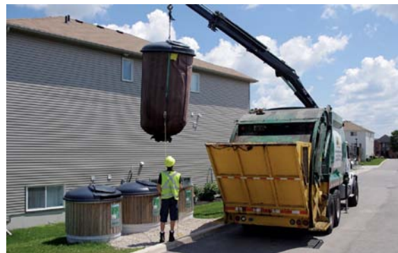
Fotografia 18. System odbioru odpadów zgromadzonych w kontenerach podziemnych Źródło: Kaliampakos D., Benardos A. (2013)
