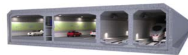
Рис. 6. Проект строительства Фемарнбельтского тоннеля. Источник: [8].
