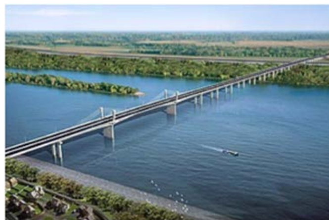
Рис. 5. Новый мост между Болгарией и Румынией. Источник: http://www.danubebridge2.com
