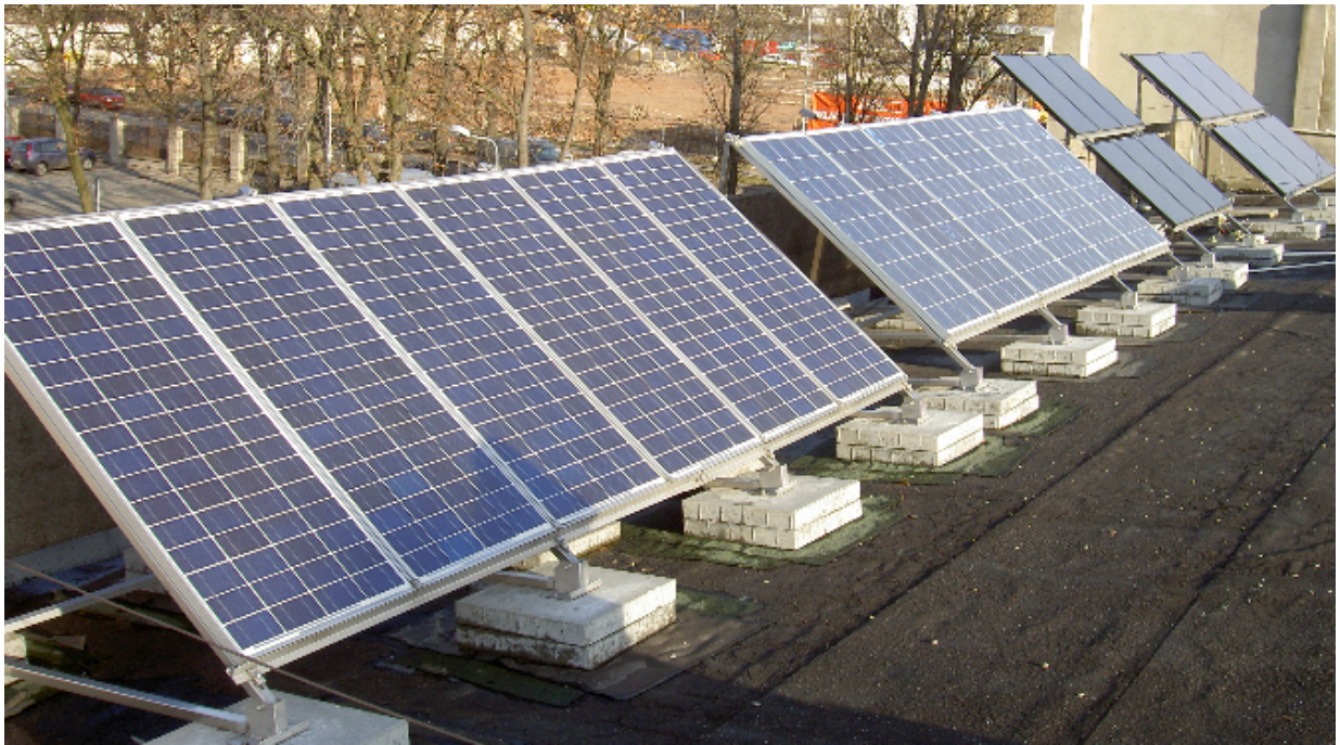
Fot 2. Wygląd konstrukcji badanej instalacji fotowoltaicznej.
