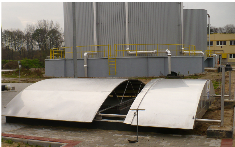
Fot. 1. Widok na nadziemną zabudowę systemu odsiarczania biogazu za pomocą rudy darniowej w firmie Rawskie Wodociągi i Kanalizacja Sp. z o.o. w Żydomicach. Własność autorów.
