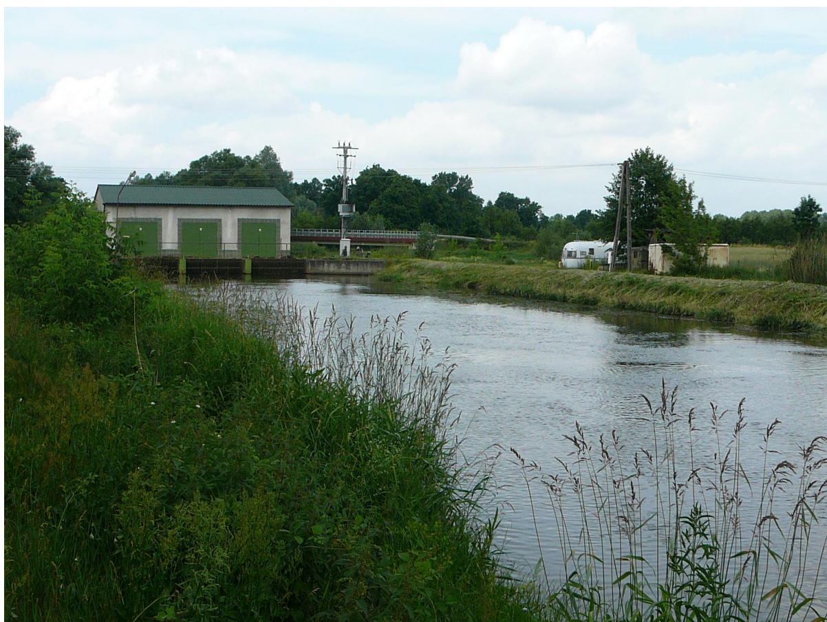
Fot. 4 Budynek siłowni elektrowni wodnej "Podgórze"
