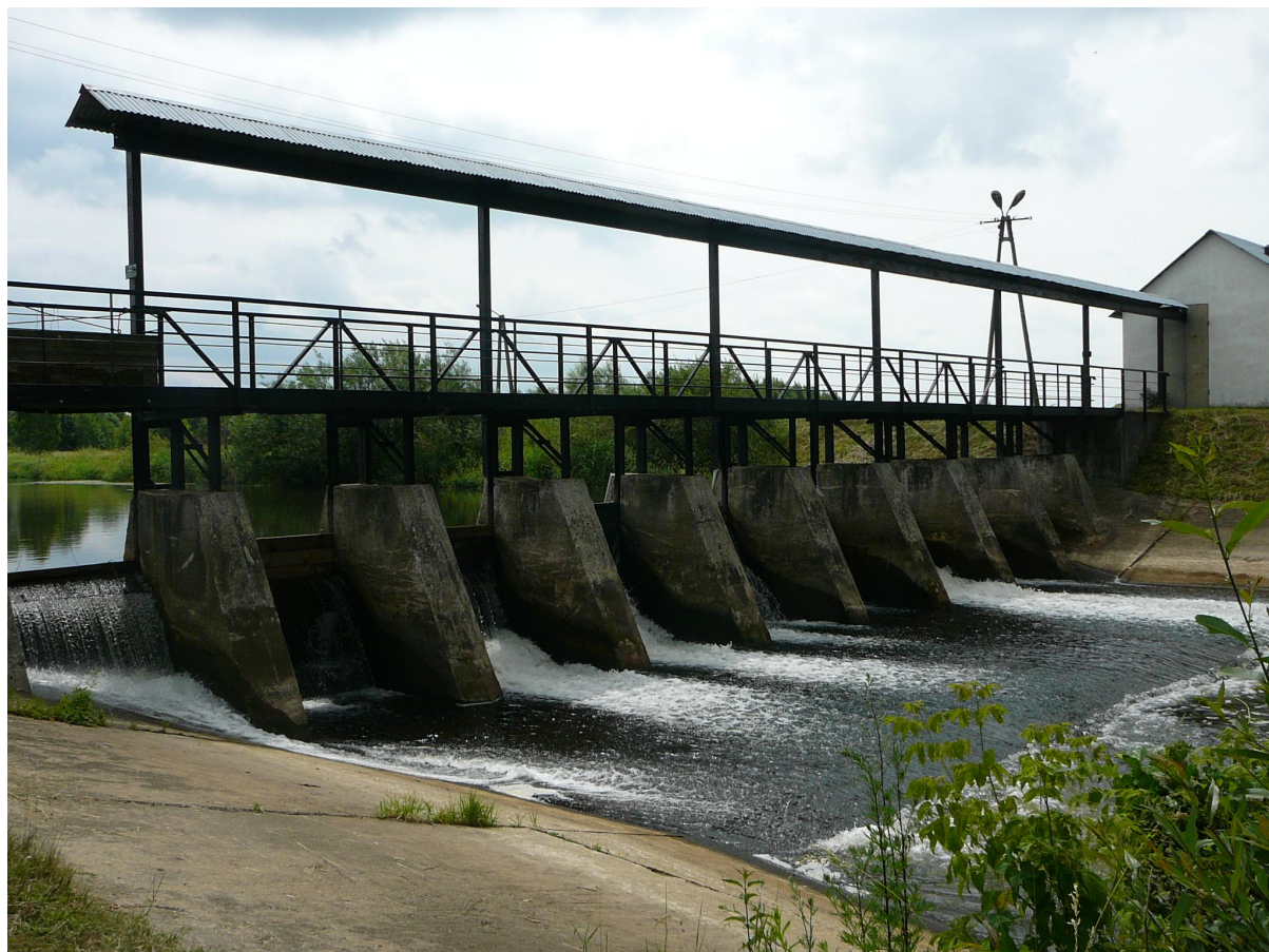
Fot. 1 Jaz na rzece Widawce
