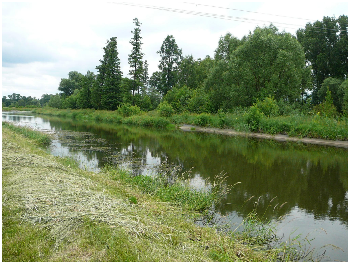
Fot. 6 Kanał wodny zasilający elektrownię wodną "Podgórze"
