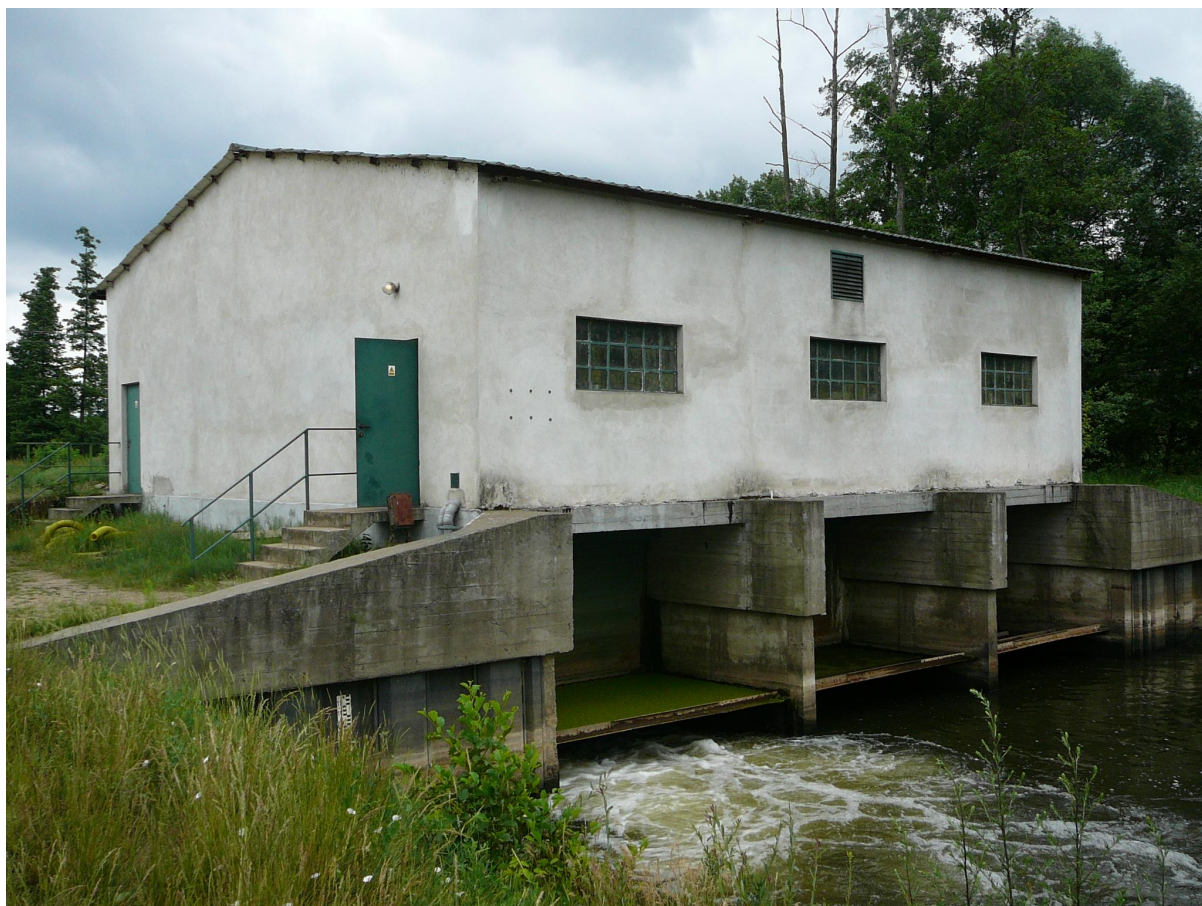
Fot. 3 Budynek siłowni elektrowni wodnej "Podgórze"
