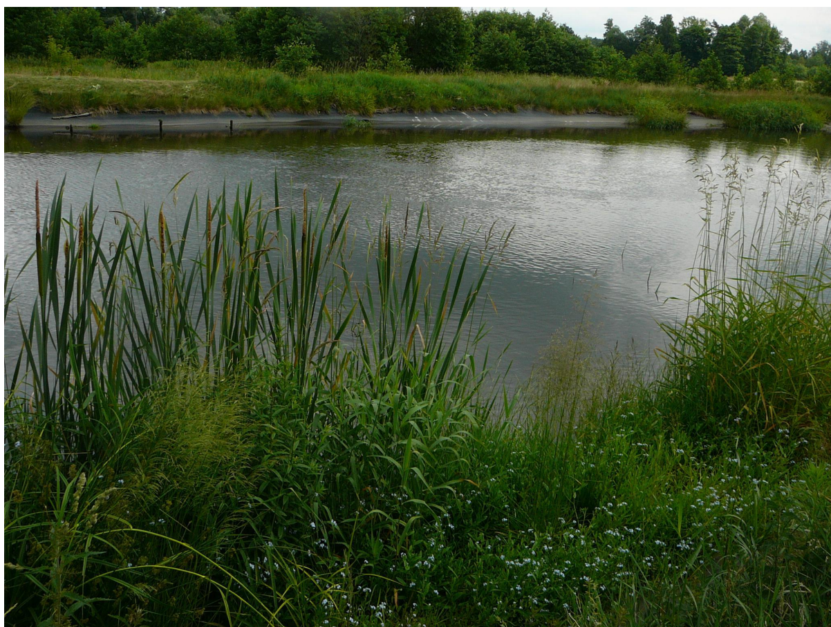
Fot. 7 Kanał wodny zasilający elektrownię wodną "Podgórze"
