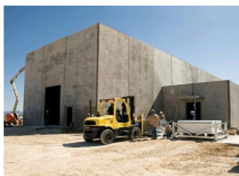
Rys. 1. Budynek mieszczący największą baterię galwaniczną na świecie [1]
