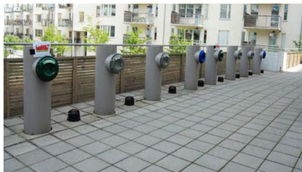
Pneumatyczny system zbiórki odpadów
