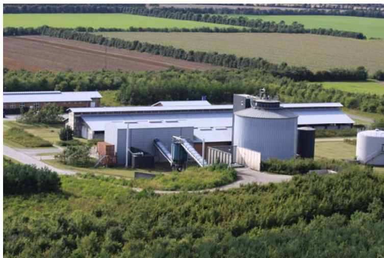
Rysunek 29. Widok na instalację fermentacji metanowej w Billund Źródło: [2]
