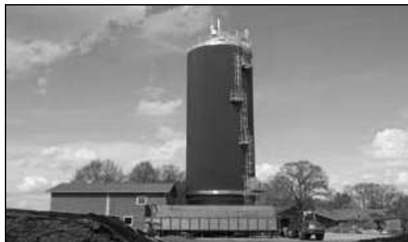
Zdjęcie 2. Instalacja do procesu suchej fermentacji
