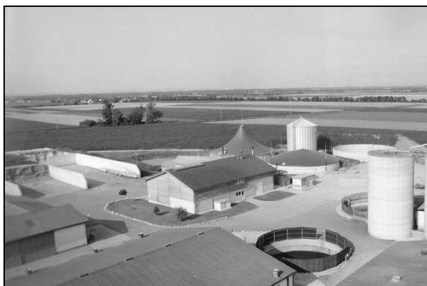
Zdjęcie 1. Biogazownia rolnicza w Reidling, Austria Przykład instalacji z kofermentacją
